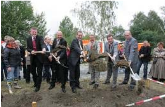
Im Gleichtakt: Ministerpräsident Matthias Platzeck vollzog gemeinsam mit dem Locon-Vorstand den ersten Spatenstich für das neue Eisenbahnwerk. Links neben ihm Gunter Schulz, rechts Harald von Ascheraden (beide vom Vorstand). © MOZ
