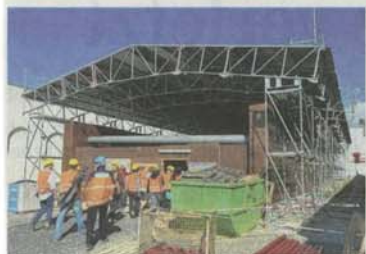
Das Baudach wird heute demontiert, um weitere Treppenteile einzuheben.
