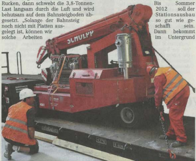
Die kleinen Hebefahrzeuge werden mit einem Diesellok in den Tunnel gefahren. Sie sind extrem wendig und können bis zu neun Tonnen Last heben.
