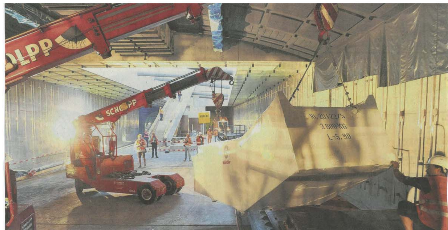
Gegen 12 Uhr hieven die beiden kleinen Hebefahrzeuge in der Tunnelstation Bayerischer Bahnhof das erste Rolltreppen-Segment vom Bauzug. Dann wird es zur Treppenanlage (im Hintergrund) transportiert. Neben der dort bereits fertigen festen Treppe sollen zwei Rolltreppen entstehen. Fotos: Wolfgang Zeyen (4)
