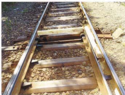
Abb. 1: Weiche nicht ordnungsgemäß gesichert
